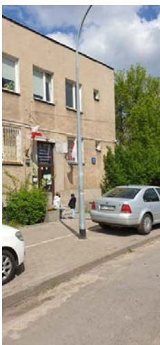
Zdj. 4. Widok na drzwi wejściowe
